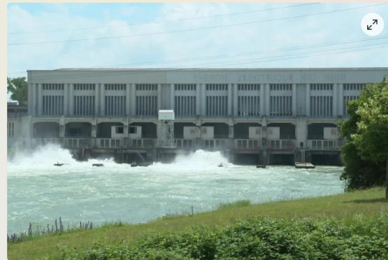
EDF modernise ses usines hydroélectriques pour un meilleur rendement • © Arnaud Rapp / France Télévisions
